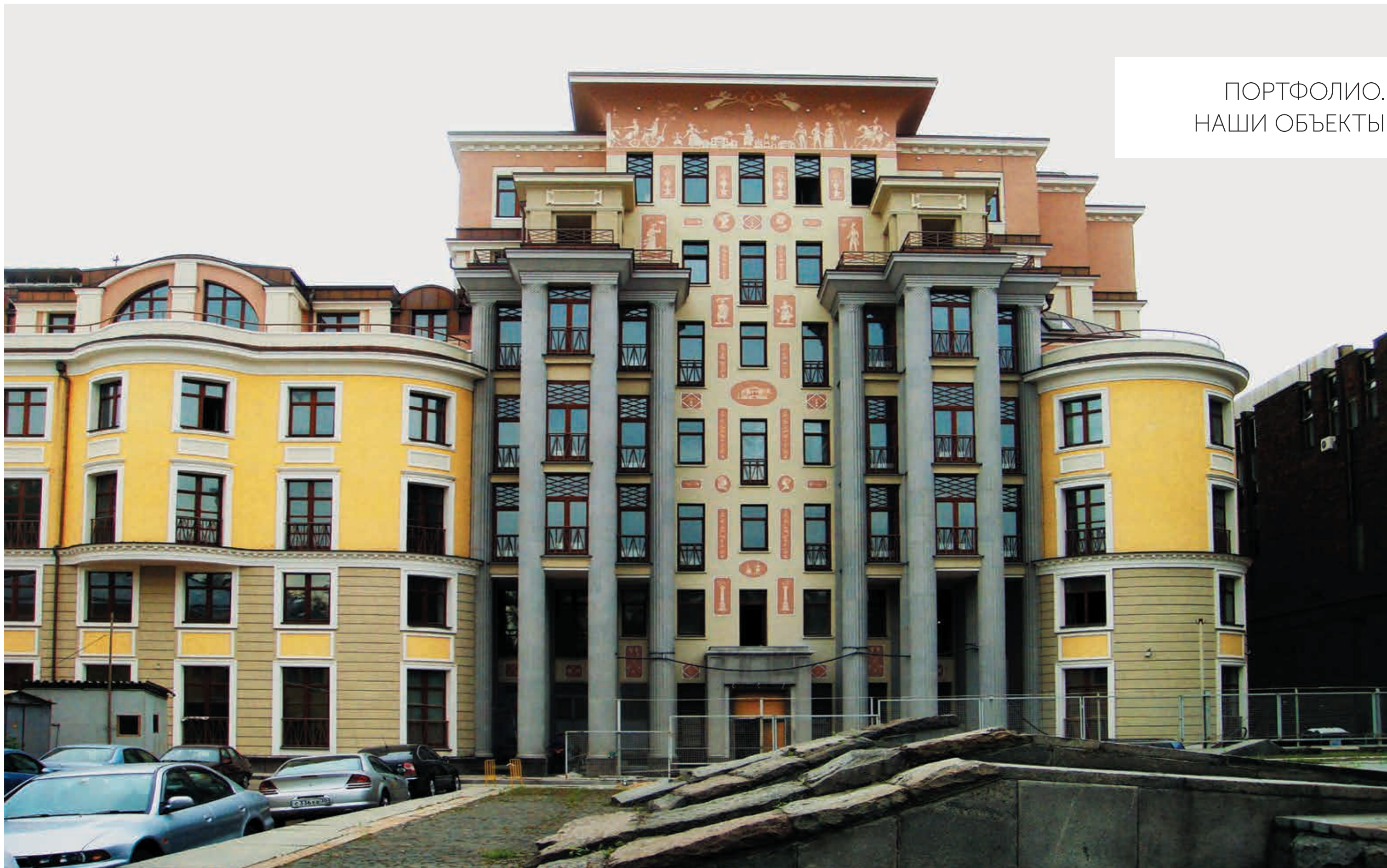
г. Москва, Большой Гнезниковский пер., 3. Жилой комплекс
