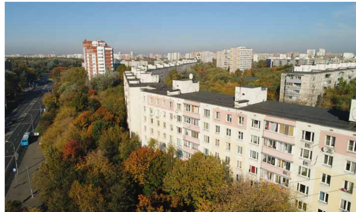
г. Москва, ул. Вешняковская, 1к2, 1к3, 5к1, 5к2, 5к3. Многоквартирные дома
