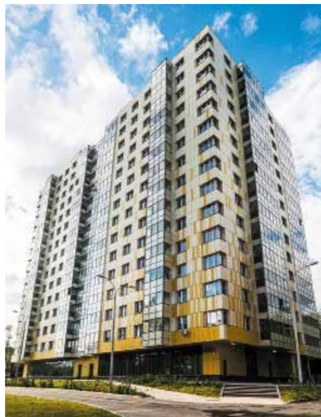
г. Москва, ул. Гжатская, 16к1. Многоквартирный дом
