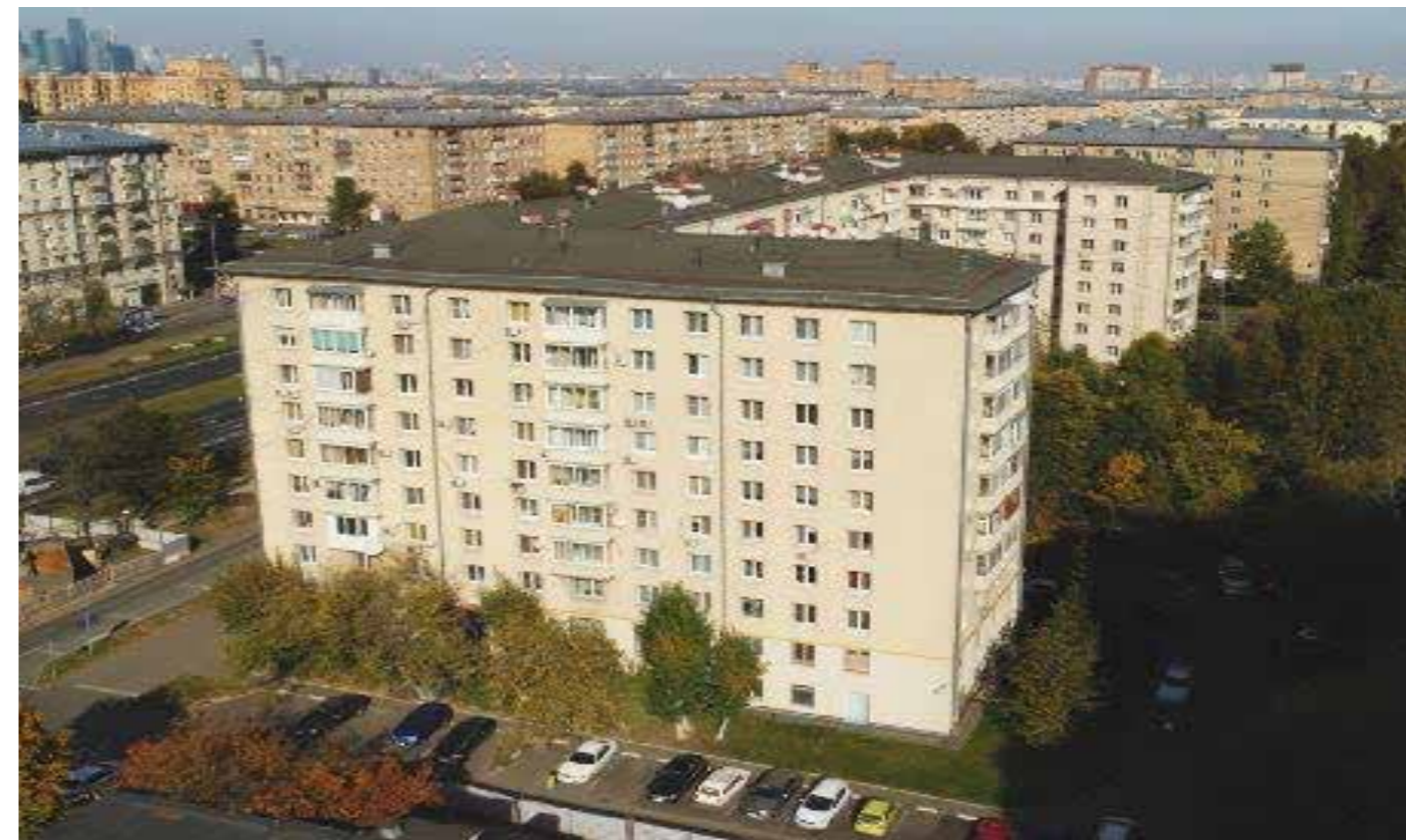
г. Москва, Ленинский пр-кт, 75/9. Многоквартирный дом
