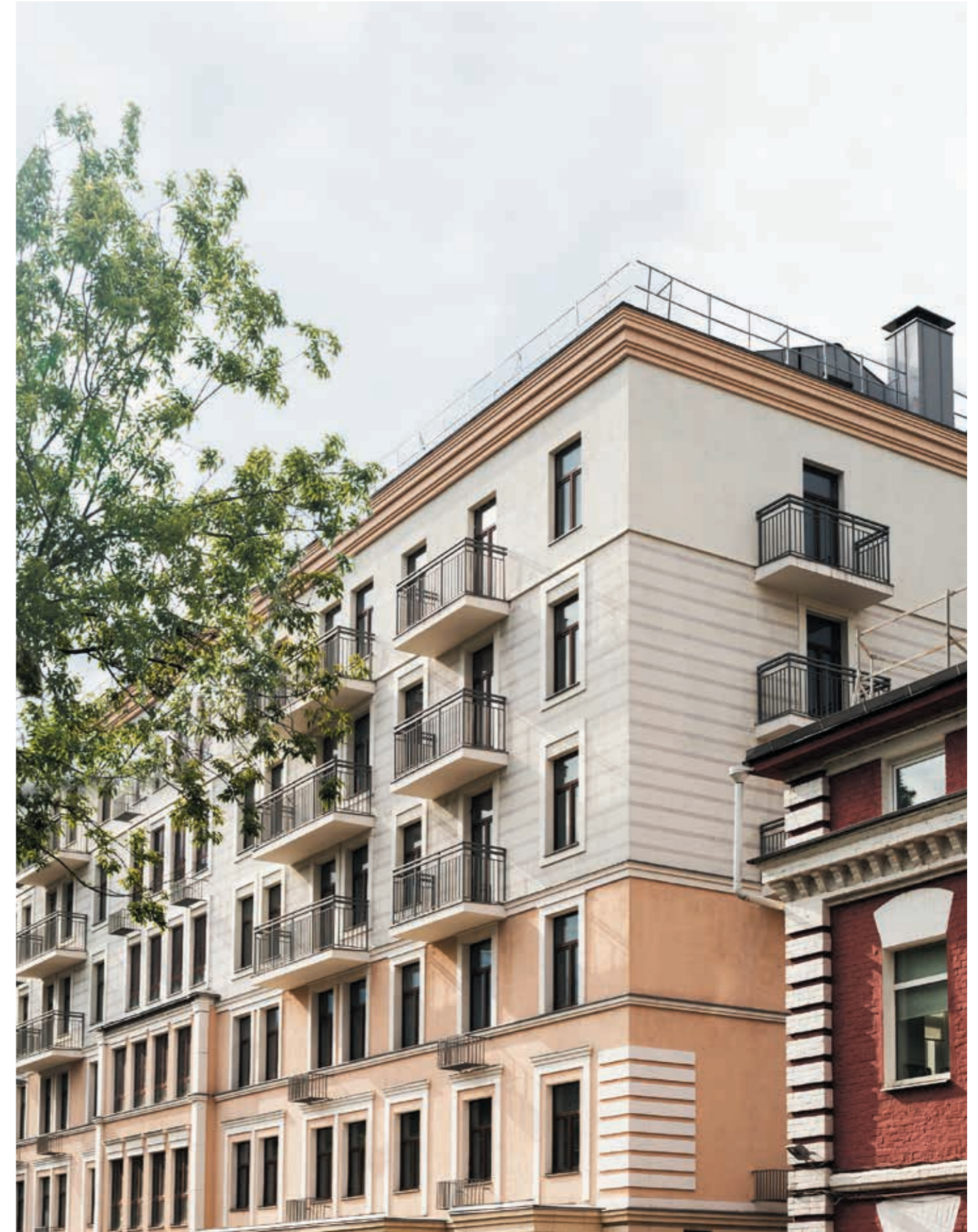
г. Москва, Тишинский пер., д 43/20. Фасадная система THERMOMAX
