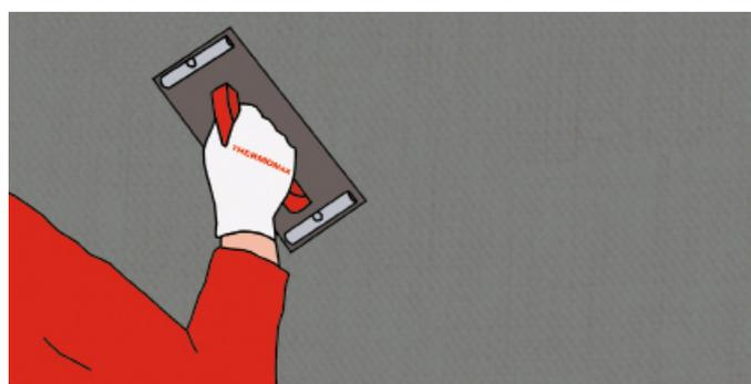
6. Поверхность смонтированного базового штукатурного слоя не должна иметь неровностей. Перепады на длине поверхности в 1 метр не должны превышать величину, соответствующую максимальной величине зерна декоративной штукатурки плюс 0,5 мм, которая наносится следующим этапом. Все неровности должны быть удалены путем шлифования поверхности.
