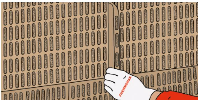
16. При неплотном прилегании плит друг к другу и наличии зазоров более 2 мм необходимо заполнить их клиновидными полосками, вырезанными из теплоизоляционной плиты.
