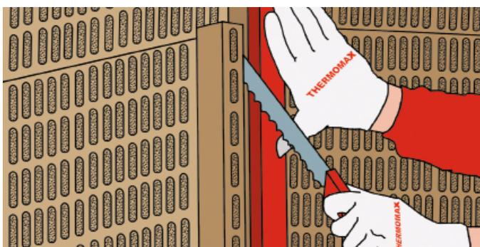
13. Излишки плит на торцах срезаются ножом после высыхания клея, после чего поверхность среза зашлифовывается специальной теркой.
